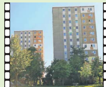
Baustand Anfang September 2009 – die alten Loggien sind demontiert
