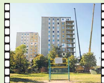
Die Montage der neuen Loggien ging zügig voran
