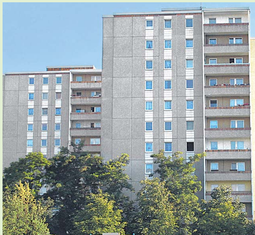
August 2009 - vor Beginn der Baumaßnahme
