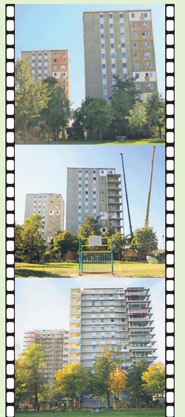
Alle neuen Loggien sind montiert - jetzt wird gedämmt und verputzt
