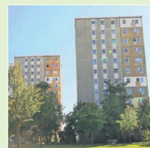
Baustand Anfang September 2009 – die alten Loggien sind demontiert
