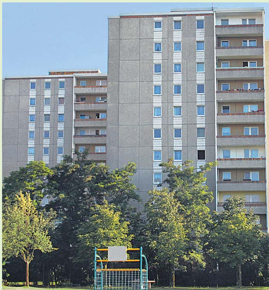
August 2009 – vor Beginn der Baumaßnahme
